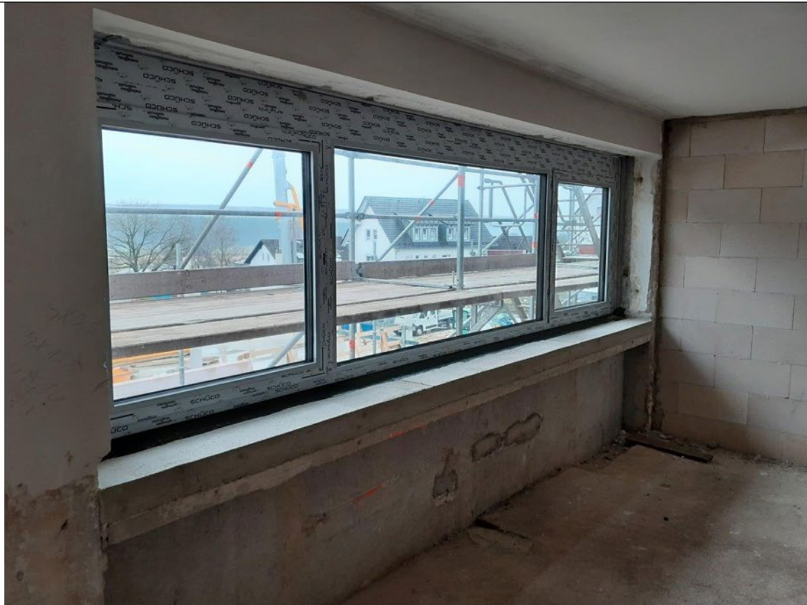
Einbau der Fenster
