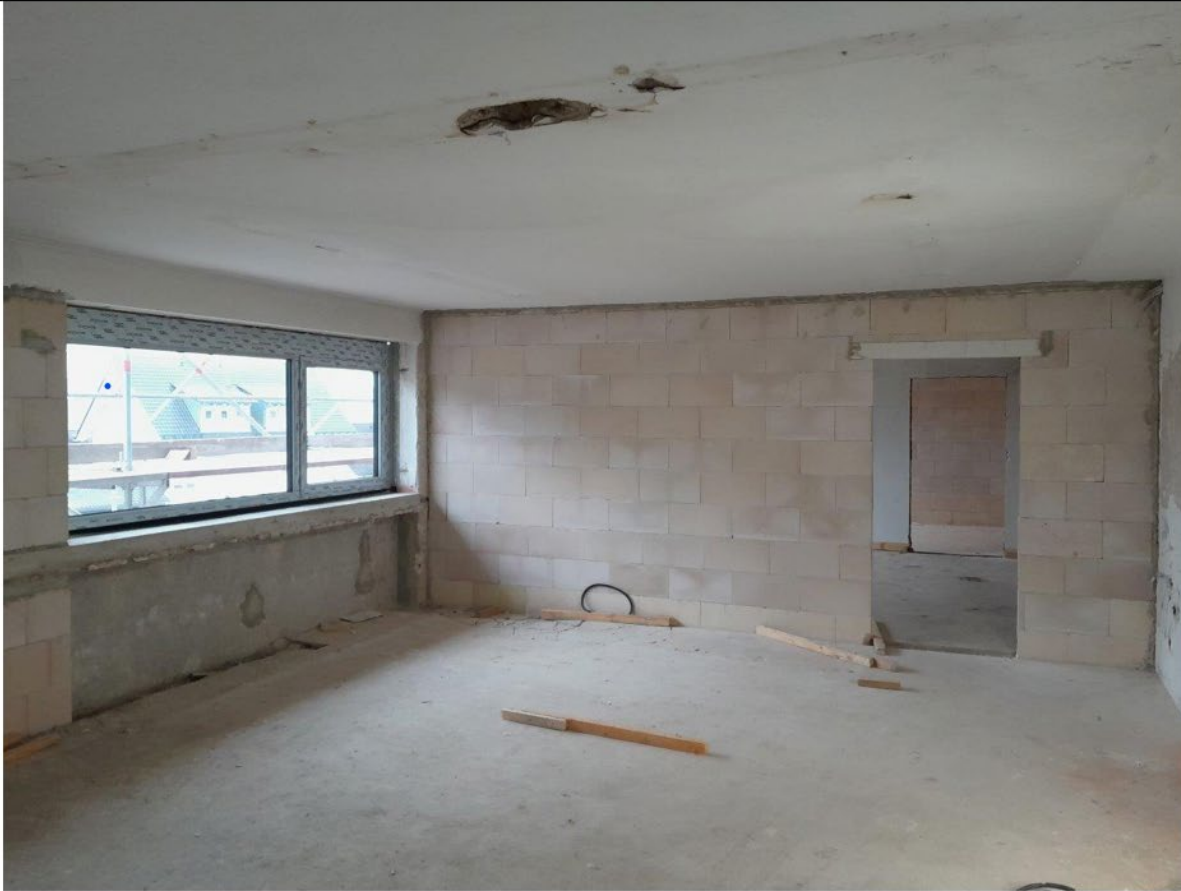
Rohbauarbeiten abgeschlossen, der Innenausbau kann beginnen.
