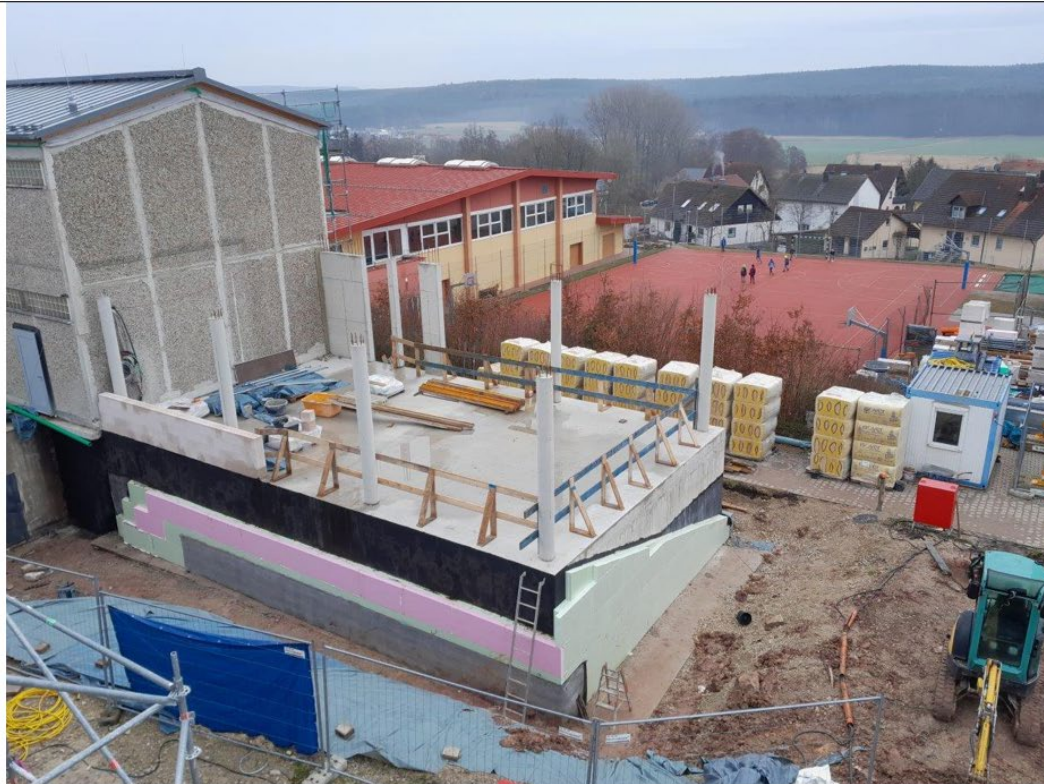
Übersicht Baustelle Bibliothek.
