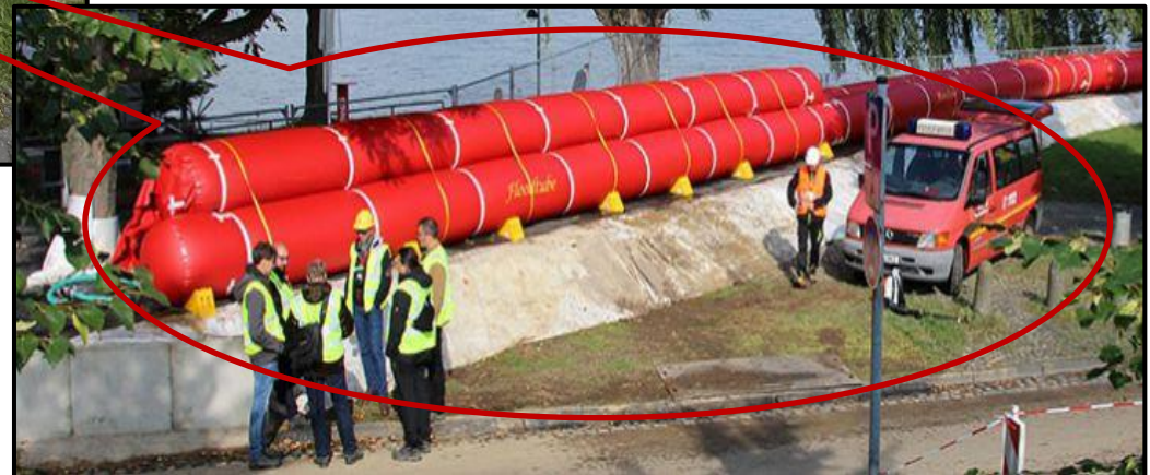
Mobiles Hochwasserschutzsystem „Floodtube“ Beispielfoto
